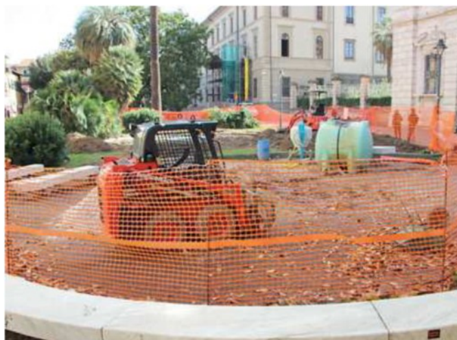
I lavori di riqualificazione di piazza Dante
