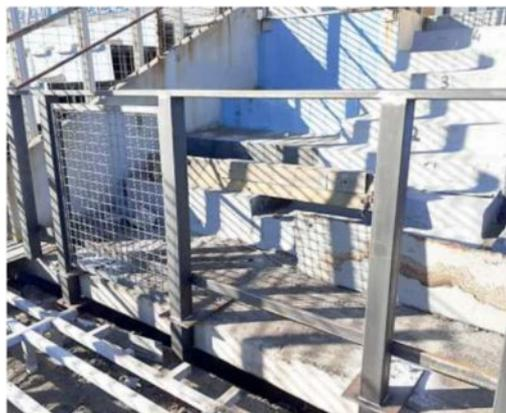
Nella foto l'inizio delle prove della nuova balaustra che sarà installata quando i gradoni bassi saranno stati demoliti e quelli nuovi prefabbricati saranno in fase di montaggio
